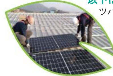
ツバキ・ナカシマ・イタリア - アスベストの屋根の撤廃と省エネルギー：アスベストの屋根の後継として、311.85kWpの合計945枚の単結晶太陽光発電モジュールを設置しました。
